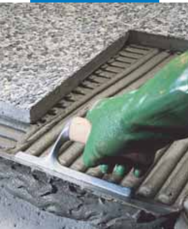
Pose de granito en relief à l'extérieur
