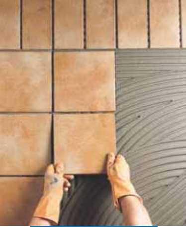
Pose de grès étiré à l'extérieur
