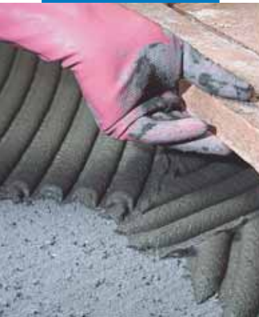
Pose de terre cuite artisanale sur chape désolidarisée
