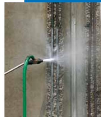
Décapage des fers par hydrosablage
