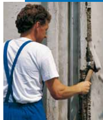
Démolition du béton dégradé
