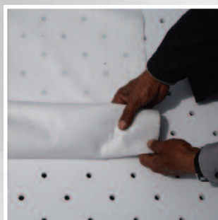
3. Pose de la couche filtrante (facultative)
