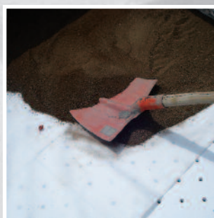
4. Pose de la terre végétale
