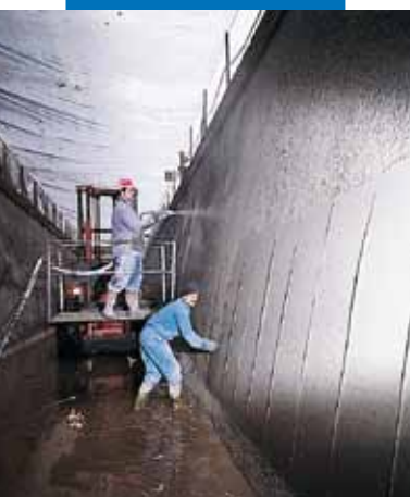
Canal hydroélectrique Bertini - Robbiate (Como - Italie): lissage
