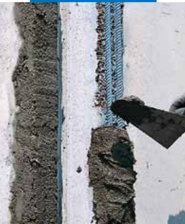
Application sur béton
