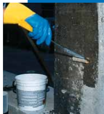
Application éventuelle de la 2 ème passe de Mapewrap Primer 1
