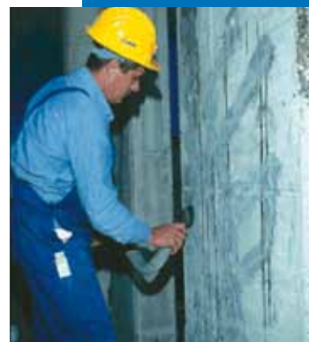
Préparation du support
