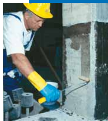
Application de la 1 ère passe de Mapewrap Primer 1
