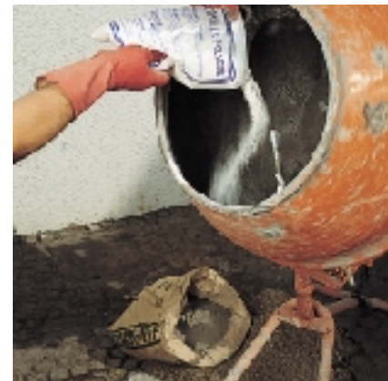
Préparation du mortier idrofuge adjuvé avec la POUDRE IDROSILEX
