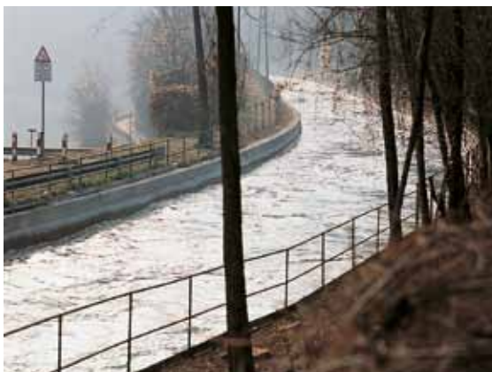
Canal Bertini - Robbiate (CO) impermeabilisé avec Idrosilex Pronto
