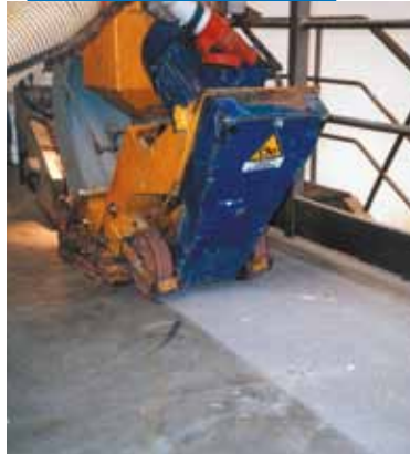
Préparation du support par grenailage
