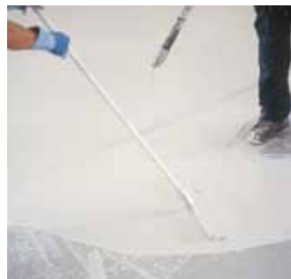
Application mécanique d' Ultratop
